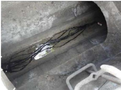
Les bandes sont placées sur le radier de la canalisation de manière à flotter sur 1 mètre dans les eaux usées. Leur flexibilité et leurs ondulations évitent l'accumulation de dépôts et un colmatage éventuel du tronçon.
