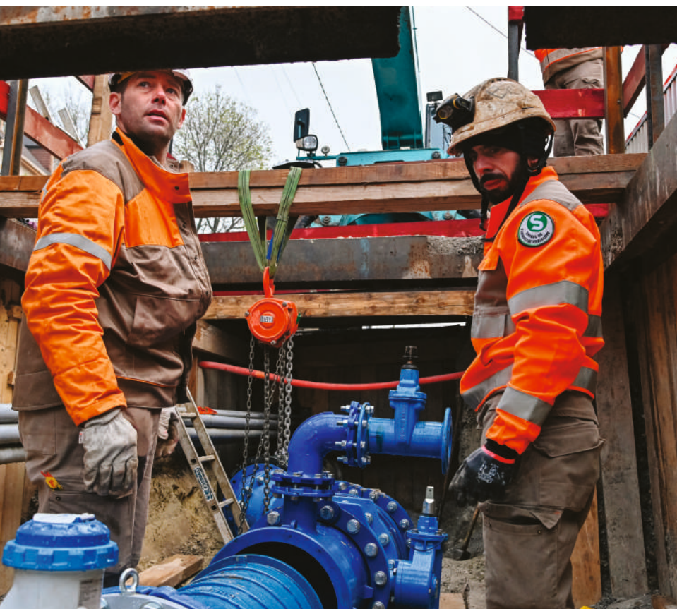
Montage d'une nouvelle ligne hydraulique à Argenteuil
