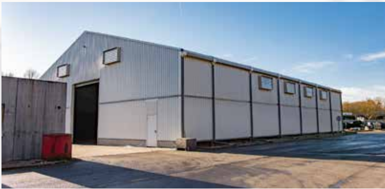
Quai de transfert
